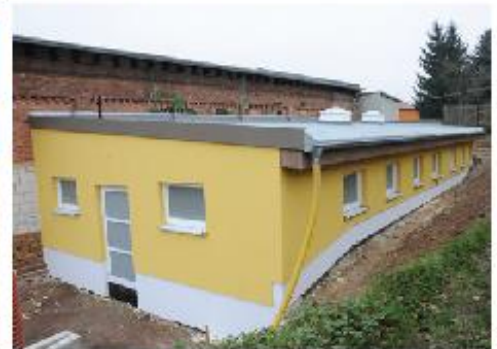
Der Anbau der Turnhalle soll Ende des 1. Quartals 2015 fertig sein.
