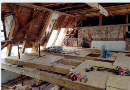
Sanierungsarbeiten am Dach des Ostflügels
