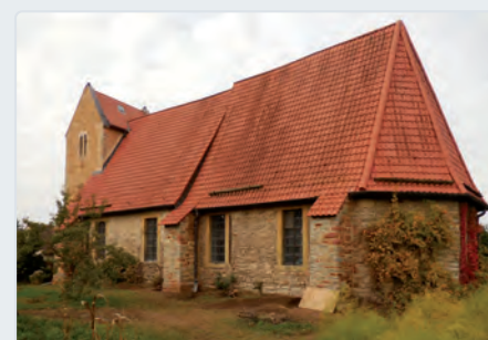
Außenarbeiten an ev. Kirche | Lüttchendorf
