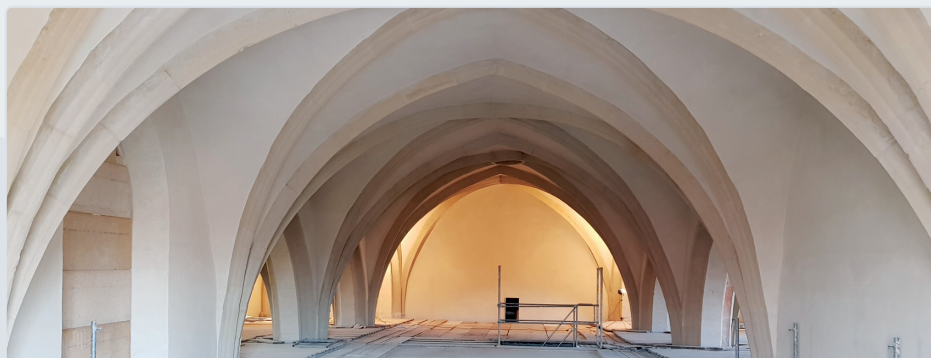
Vollständig verputzte und gestrichene Gewölbeflächen von der oberen Gerüstplattform aus gesehen Foto: Michael Schumann
