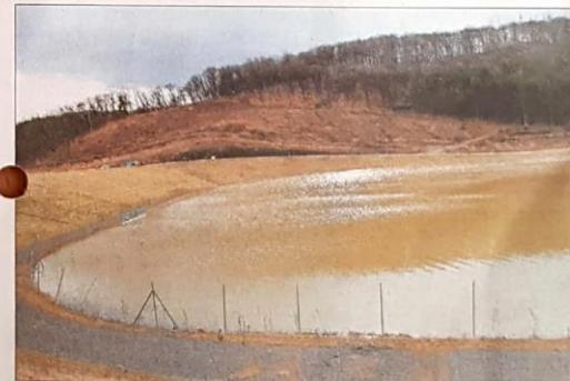
Der Probestau am neuen Hochwasserrückhaltebecken Wippra begann am 22. Februar 2022. Das Becken konnte bis zu einer Höhe von 10 Meter eingestaut werden. Das entspricht etwa 60 % der Vollstauhöhe.
